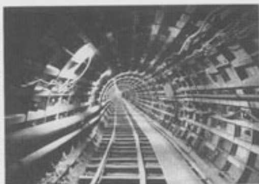
整備が進む下水道
