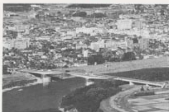
4車線化が進む中瀬大橋
