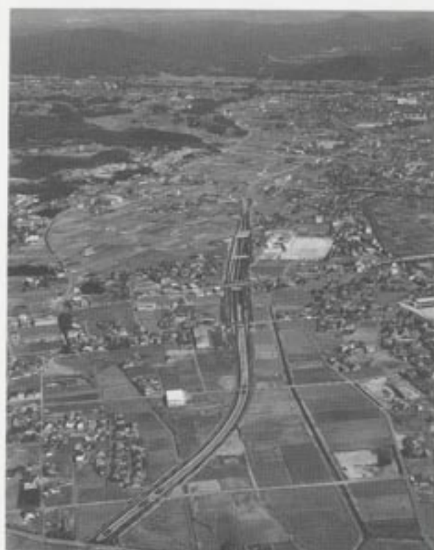
一部開通した国道248号バイパス
