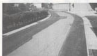
側溝が補修された市道銅米一号线
