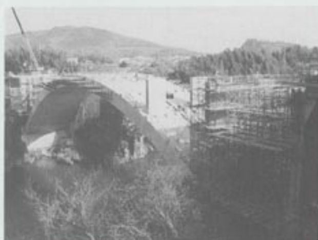
▲建設が進む青柳大橋
