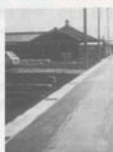
▲側溝が補修された市道細田1号線
