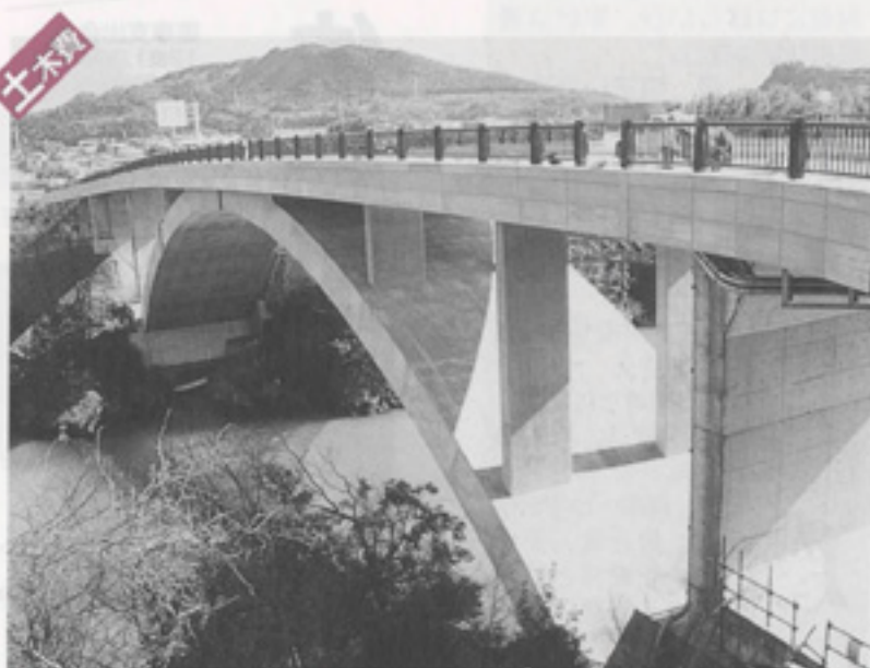
▲飛騨川にかかる青柳大橋。平成9年3月に完成予定。(森山町～下米田町)
