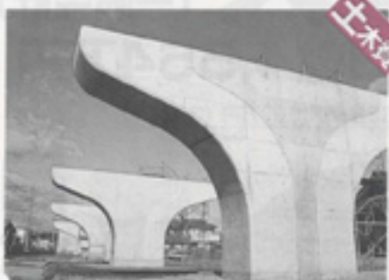
▲JR 高山線との立体交差に向け、橋脚が建ち並び西畑正理線。(本郷町)
