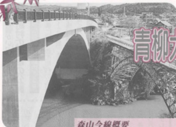
▲左の橋は完成する青柳大橋
