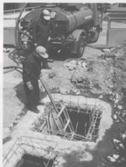
不要になった浄化槽を防火水槽に
