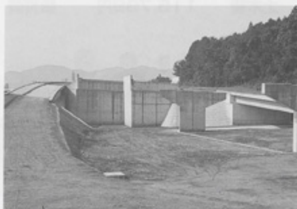
建設が進む国道41号バイパス(上蜂屋地内)
