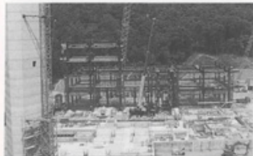
▲建設が進む「笹ゆりクリーンパーク」
