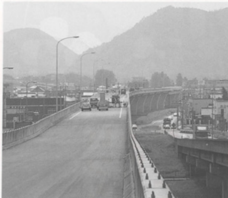
10月1日から高山方面への通行（片側暫定1車線）ができるようになった 国道41号名濃バイパス平塚高架橋
