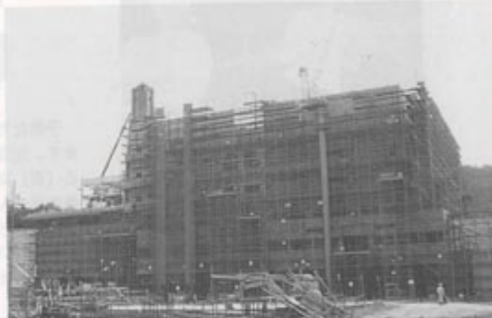
▲建設が進む(仮)笹ゆりクリーンパーク
