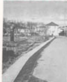
▲側溝が改良された市道細田2号線
