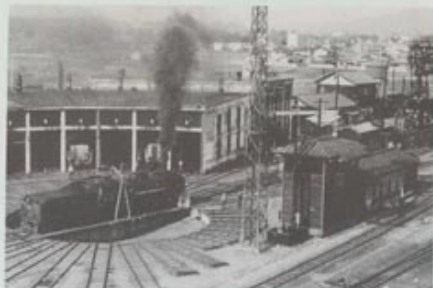
◀ 昭和40年代にあった美濃太田機関区車庫と転車台。転車台は電動式だった (資料提供：渡辺成幸さん)
