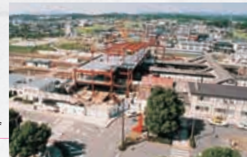
●建設中のJ R 美濃太田駅新駅舎 (平成9年)
