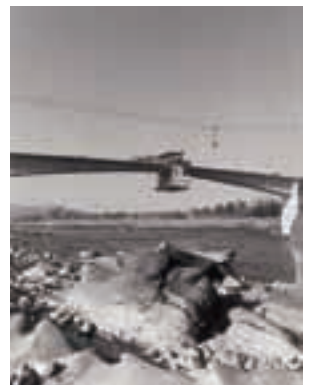
▲工事中の中濃大橋（S43）
