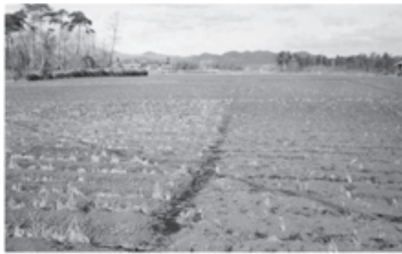
加茂野変電所北側（昭和 36 ～ 37 年ごろ）
