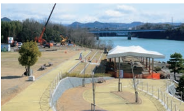
▲整備工事中の中之島公園
