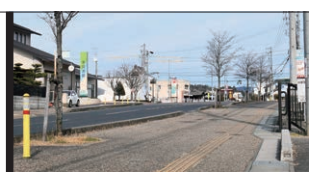
道路施設補修点検事業 土木課
